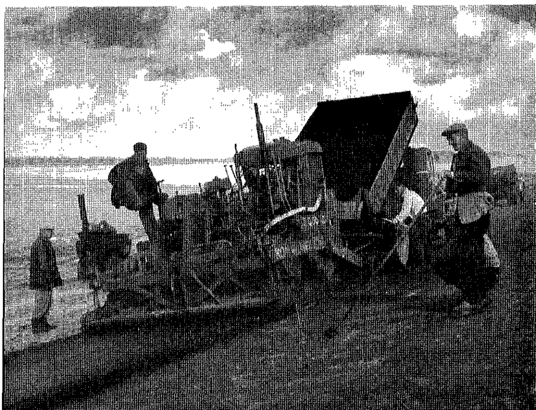
Het aanbrengen van de bovenlaag van asfaltbeton
