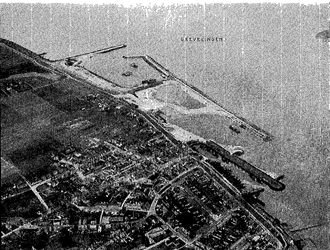
De werken bij Bruinisse op 29 december 1958
